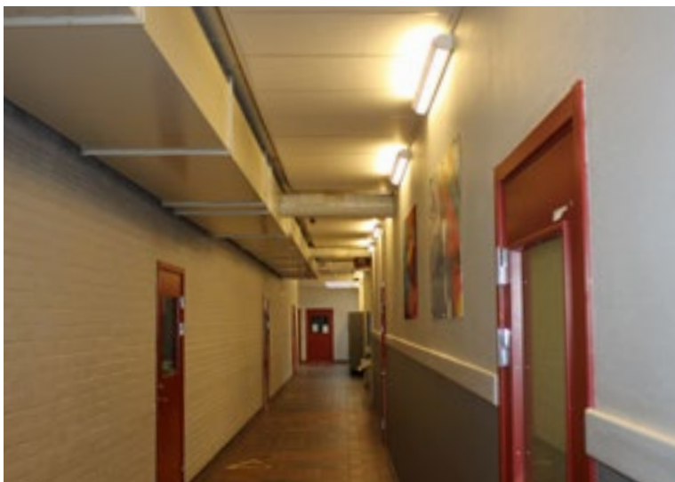
Tidigare installation i korridor.
