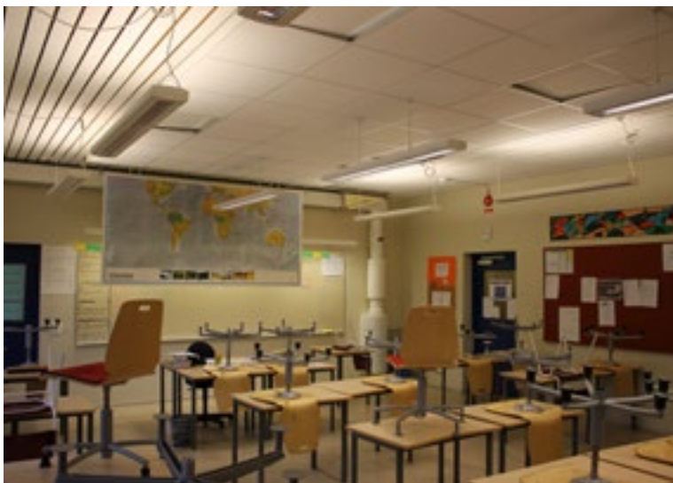
Den tidigare installationen med äldre T5-armaturer.
