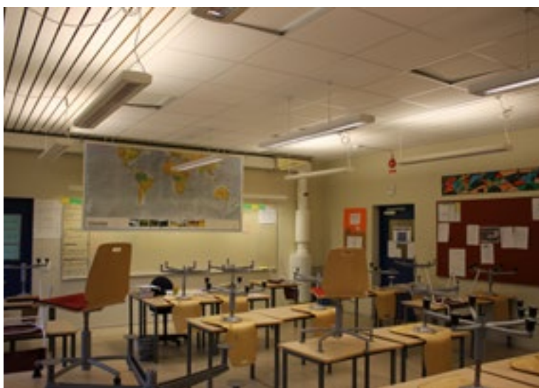
Den tidigare installationen med äldre T5-armaturer utan reglering.
