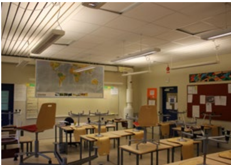
Den tidigare installationen med äldre T5-armaturer.
